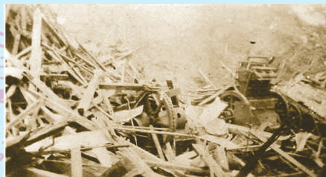
La Mina destruida.
